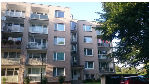
Uliční jižní fasáda
